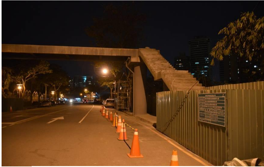
較荒涼或緊鄰工地的路段，在夜晚恐較有安全之虞
