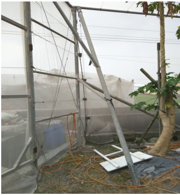
圖 1、網室 4 個角落角柱用 3 英吋(含)以上鍍鋅管，並在周邊以 3 英吋(含)以上鍍鋅管設置斜柱。
