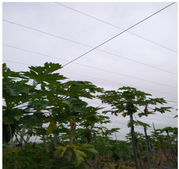
圖 6、在斜柱與相對斜柱周邊，以可支撐強風侵襲之鋼索線牽引，利於塑膠網固定。
